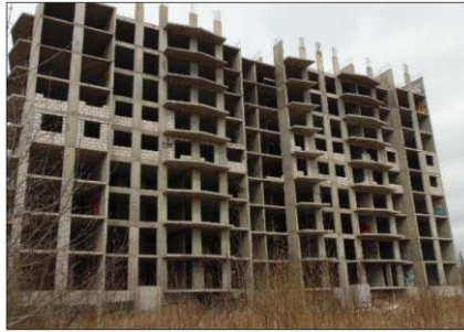
Рис. 3. Частичная кладка наружных стен из газосиликатных блоков
