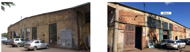
Рис. 2. Фотофиксация фасадов объекта перепрофилирования
