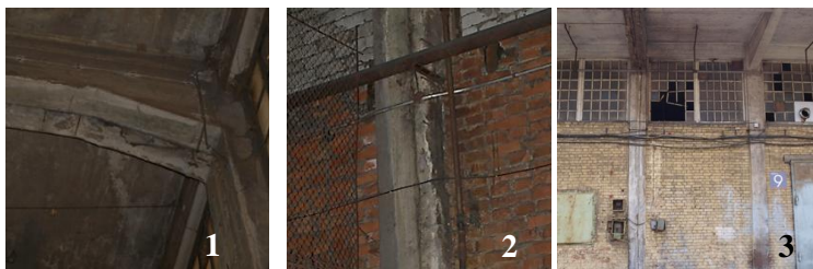
Рис. 1. Фотофиксация технического состояния строительных конструкций:
